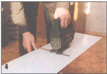
4 Распилил панель вдоль пополам, прижимая упор к правой кромке.
