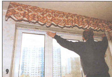
6 Измерил ширину проема в глубину на уровне оконного блока. Это и будет длина панели верхнего откоса.
