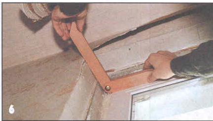
7 Замерив малкой угол между боковым откосом и оконным блоком,...
